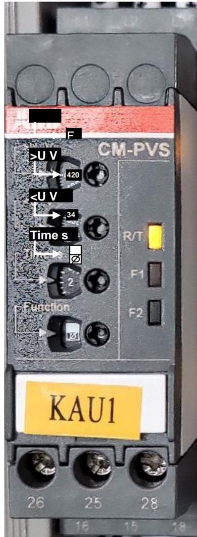
图 8-22 主控柜电压监视继电器设置值检查
